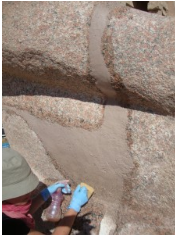
Application du mortier à base de chaux et granite sur la sculpture de Touy
