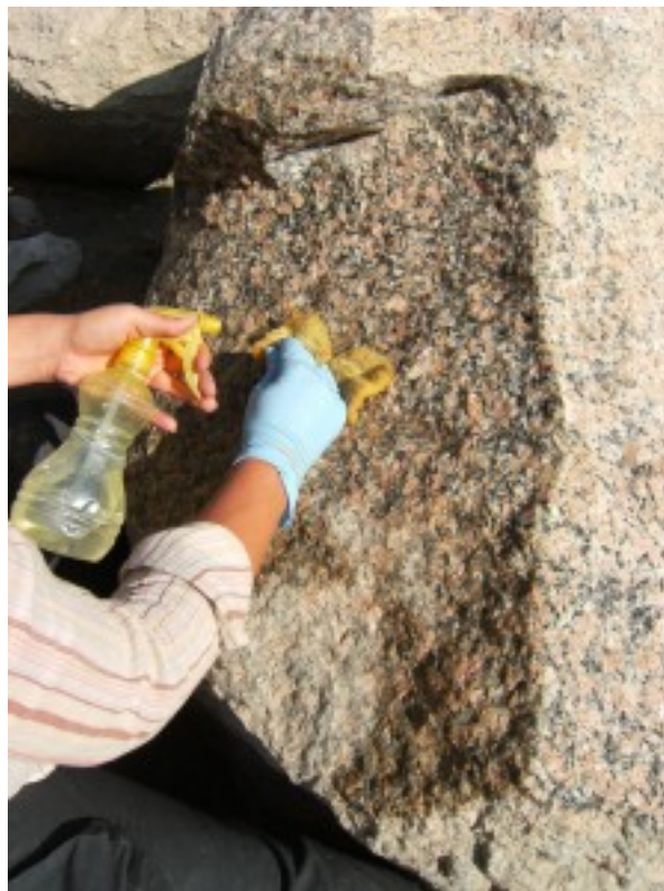
Nettoyage d'un bloc avec de l'eau et une éponge
