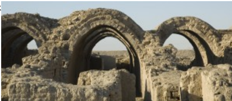
Voûtes en berceau des magasins
